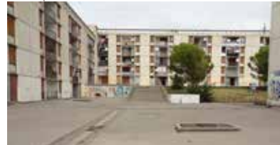
Une prépondérance de matériaux susceptibles d'échauffement
